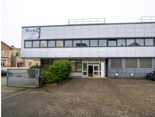
Eingangsseite mit Zufahrt
