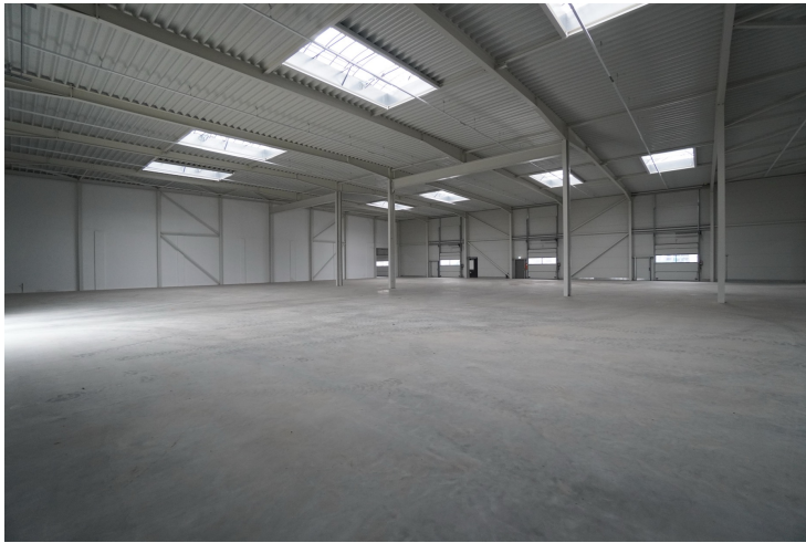
Innenansicht Halle I
