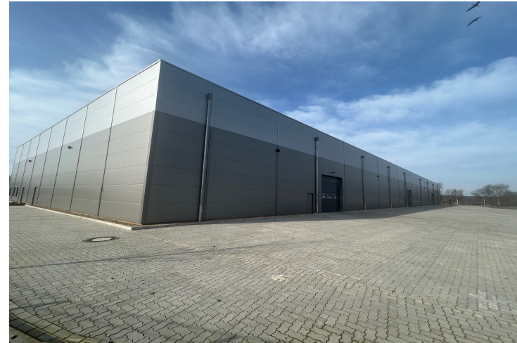
Süd-/ Ostansicht Rangier- und Außenfläche
